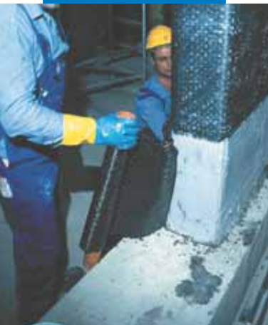
Nanošenje MapeWrap tkanine na armirano- betonski element
