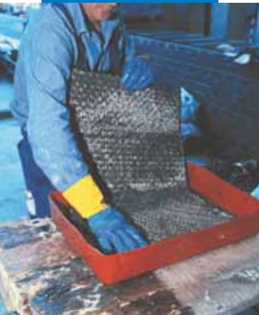
Ručna impregnacija MapeWrap-a C
